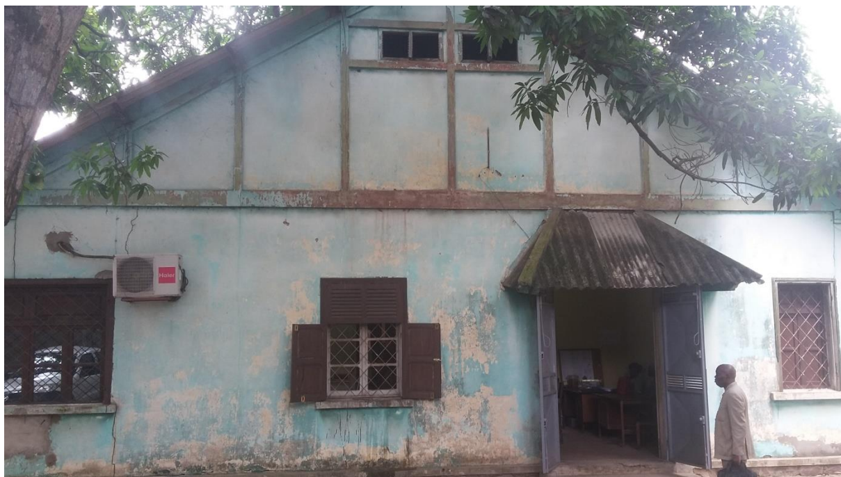
Une vue du bâtiment abritant la Direction d'Appui à la Production et de la Réglementation
